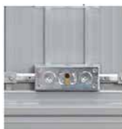
Serratura superiore a 3 punti di chiusura con piastra antieffrazione
