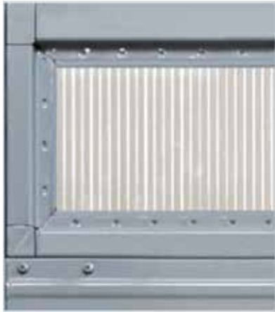
Specchiatura fissa, fermavetro e policarbonato
